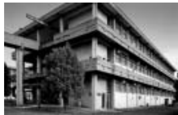
COMPLESSO INDUSTRIALE DELLA MANIFATTURA CERAMICA POZZI
