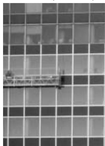
▼ 46 - 47. La sede romana dell'Eni: sezione orizzontale del curtain wall e immagine di dettaglio durante i lavori di placcatura dei profili originali
