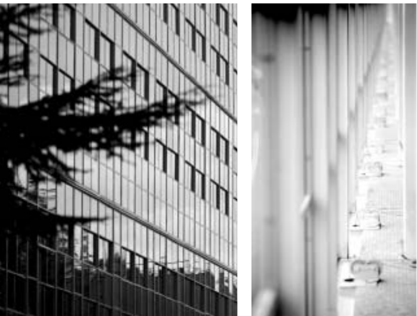
53, 54. La superficie esterna e l'intercapedine interna della vetrata su via Jervis dopo il restauro
