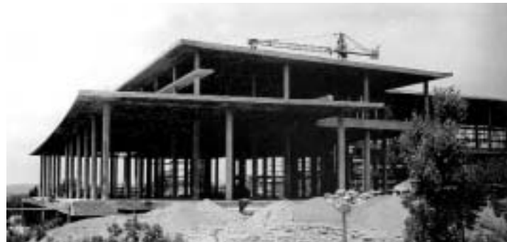
6. La struttura del corpo della direzione appena realizzata (1953)
